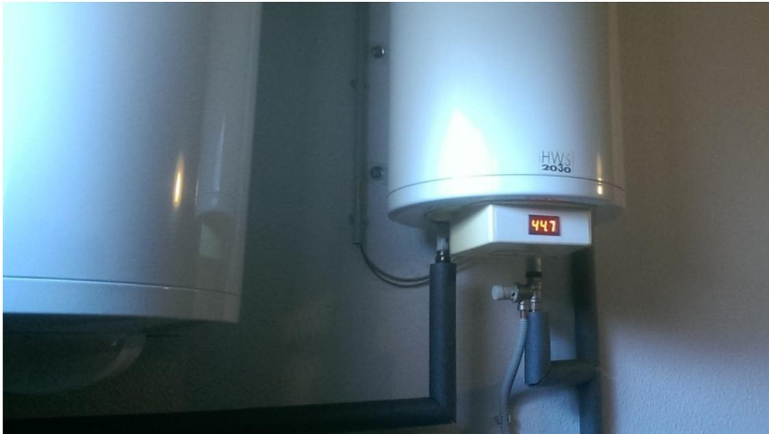
Nach einer Reinigung und Ersatz der Opferanode, konnte der Umbau auf eine Niederspannungsheizung erfolgen.
